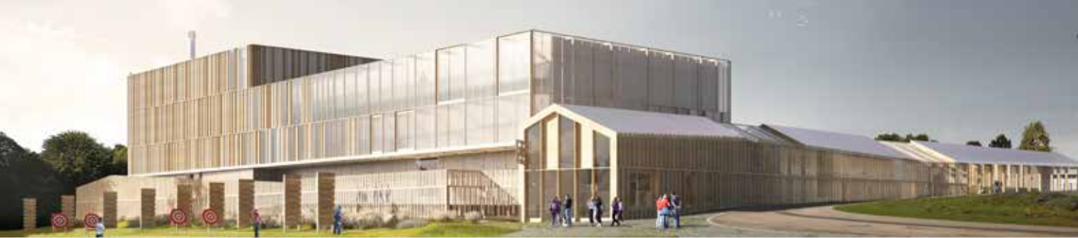
La toute nouvelle chaufferie biomasse de la Petite Bouverie fonctionne avec un combustible 100% naturel et local. (crédit photo : cabinet des deux anges)
